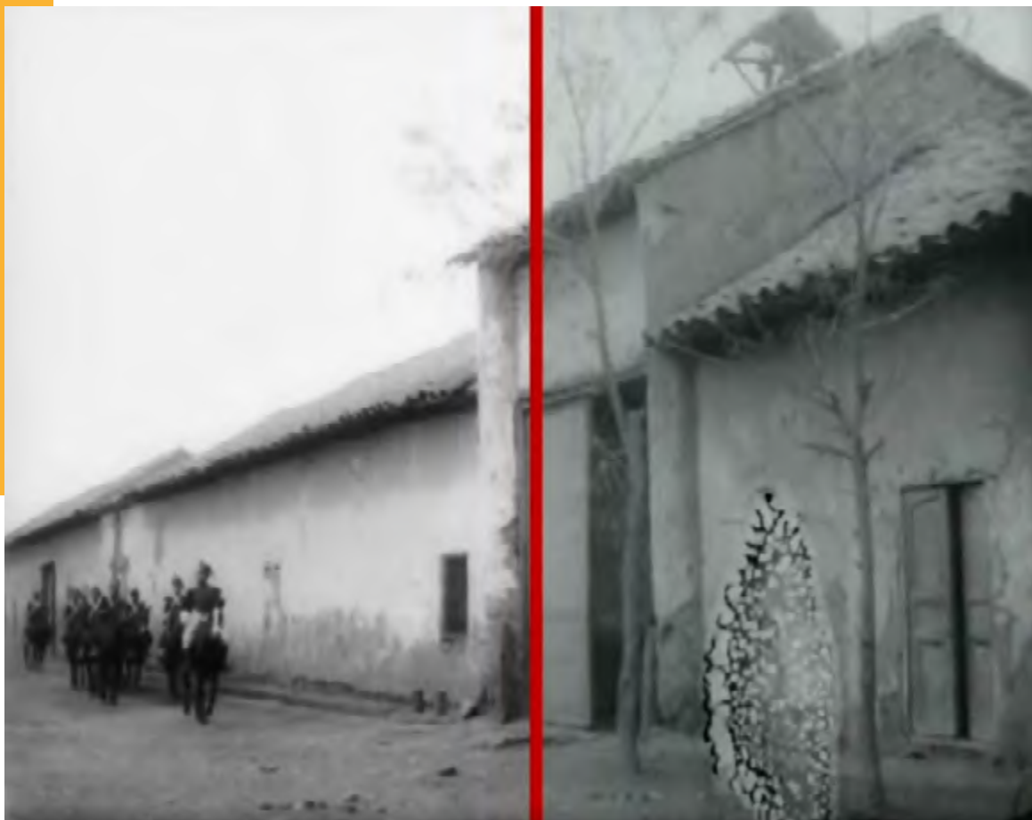
Comparativa restauración Cineteca Nacional: limpieza de hongos, manchas y rayas.
